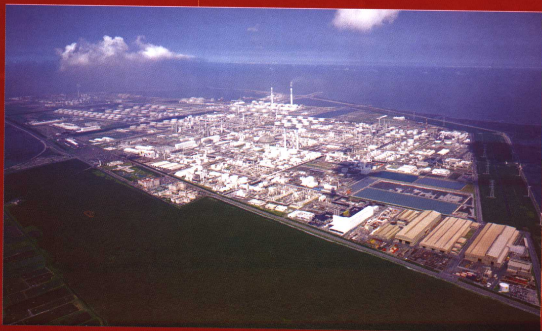
占地约32平方公里的六轻厂 区全景
