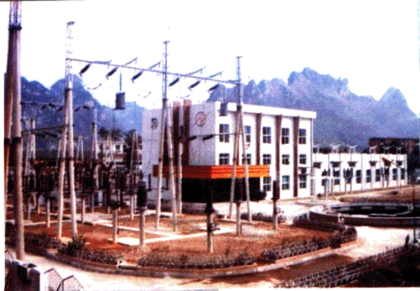
新建110千伏金城江变电站外貌
