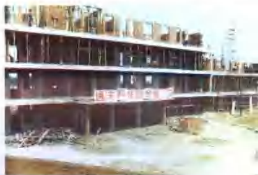
■ 正在建设中的逸夫科技楼 (1997年7月)
