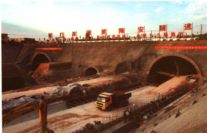
中国第一条海底隧道厦门翔安海底隧道建设全面动工。 郑杰 摄
