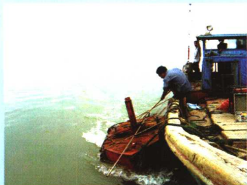
跨海大桥水域物探
