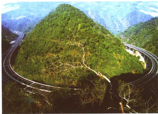
龙长高速公路建安关高架桥
