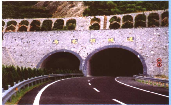
马宅顶隧道(不对称式连拱隧道)
