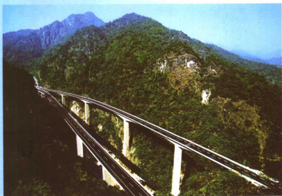
龙长高速公路石崆山高架桥
