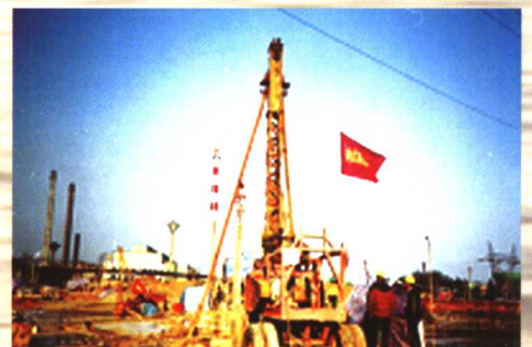
柳钢100t转炉桩基础施工工地
