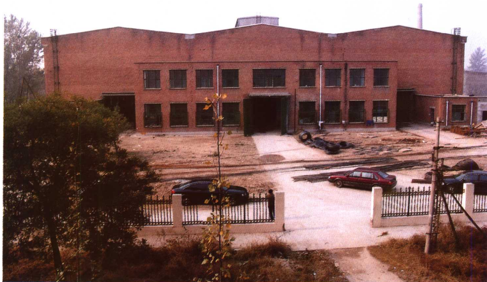
◀ 建设中的固安 产业基地
