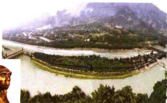
都江堰水利工程
