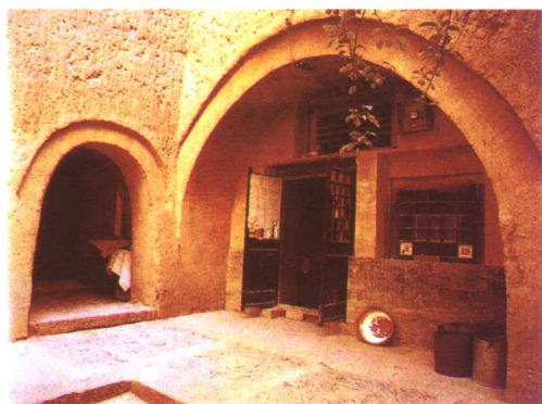
图 1-17 山西平遥石头坡的窑洞式民居
