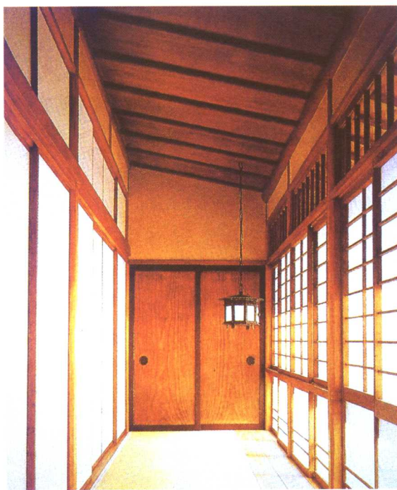
图 1-10 这间古老的日本木构小旅馆建于郊区， 新做的移窗门并非像传统那样四扇都可以活动，而只 能打开其中的两扇
