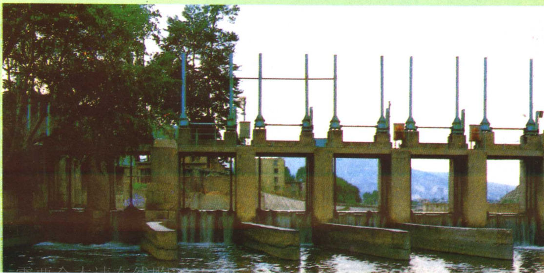
▽北川渠进水闸
