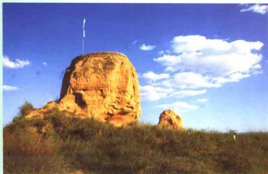
明代墩墩大明墩
