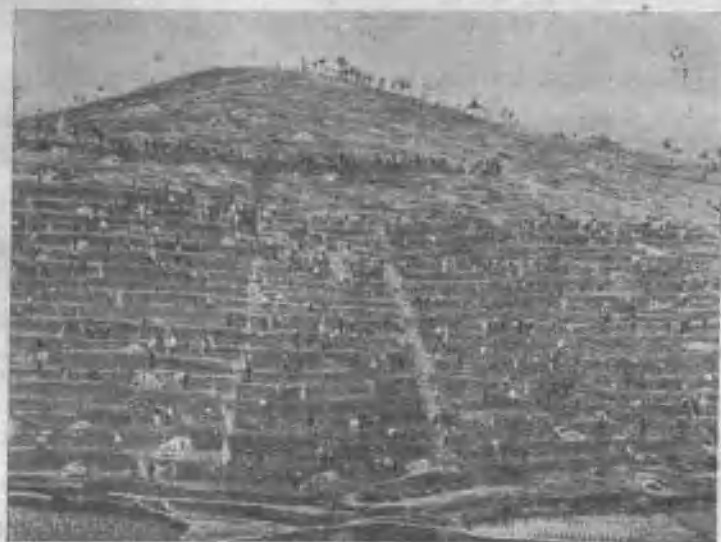
五华县华城乡城鎮农业社社員在山坡上修梯田
