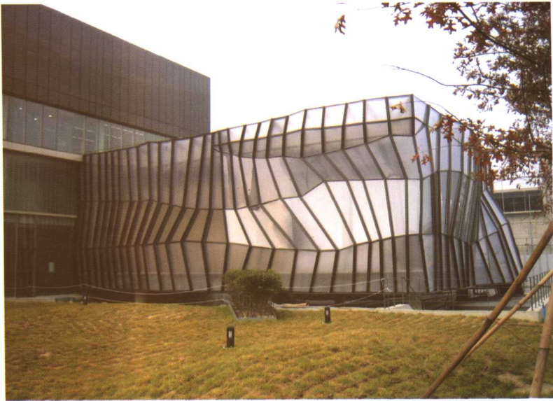
图 1-4 扭曲的玻璃幕墙背后蕴涵着技术和工艺的进步。
