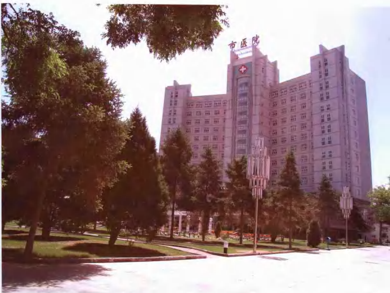
2004年5月24日新建住院部大樓竣工并投入使用
