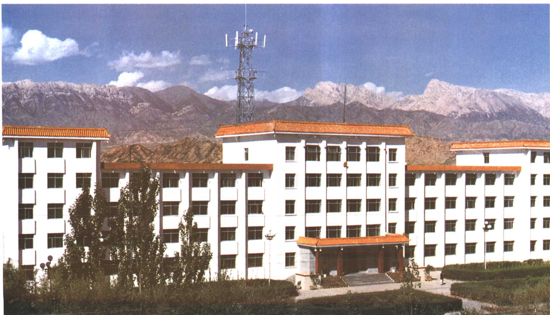
▼ 中共德令哈市委员会、德令哈市人大常委会 德令哈市人民政府、德令哈市政协办公大楼（秦建文 摄）
