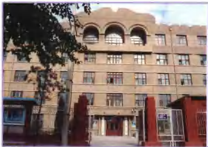
内蒙古自治区地震局旧办公楼
