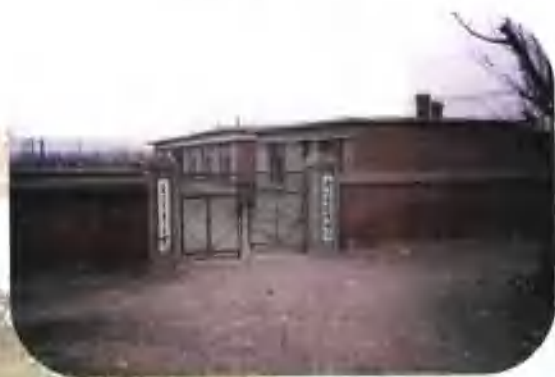
通辽地震观测站全貌
