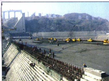
下游面预制混凝土块模板
