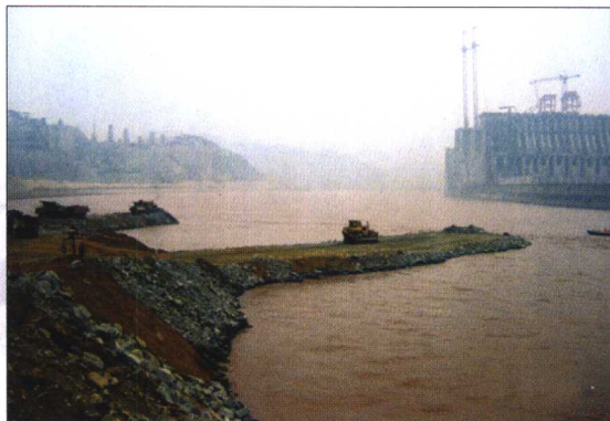
导流明渠截流戗堤进占施工
