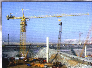
顶带机安装（高程94.7~113m采用 汽车运输和塔顶带机联合入仓，高程 113m以上全部采用塔顶带机入仓）
