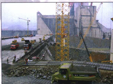
汽车入仓（高程94.7m以下 堰体混凝土）
