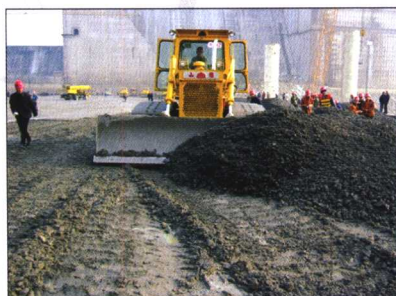
摊铺施工作业
