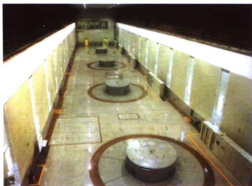
广州抽水蓄能电站二期
