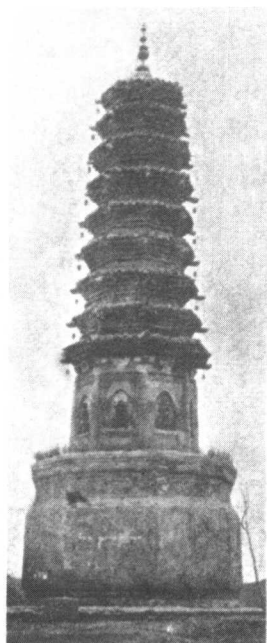
乙 遼寧鐵嶺龍首山磚塔
