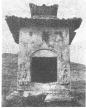
甲 河北涞水縣水北村唐石塔
