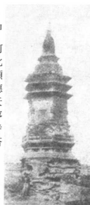
甲 河北順德天寧寺塔
