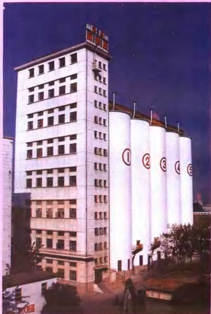
洛阳市第二粮库钢筋 混凝土筒库及工作塔
