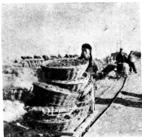
工地上推車的軌道
