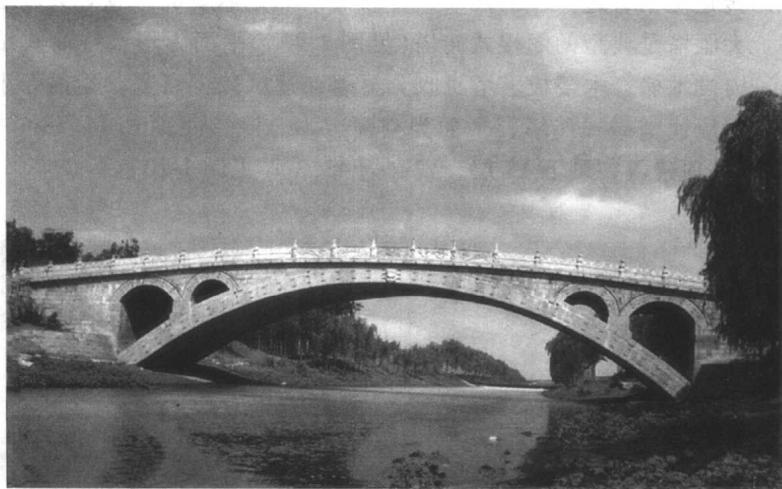
图 1-7 河北赵县安济桥
