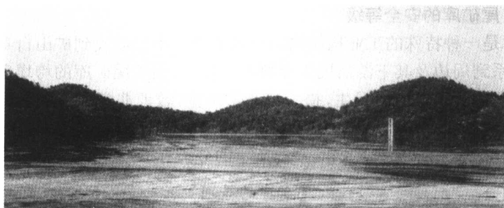
图 1.2 山谷型尾矿库实景图
