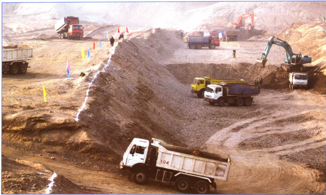
■ 2003 年 12 月，南水北调中线京石段应急供水工程永定河倒虹吸工程开工建设。
