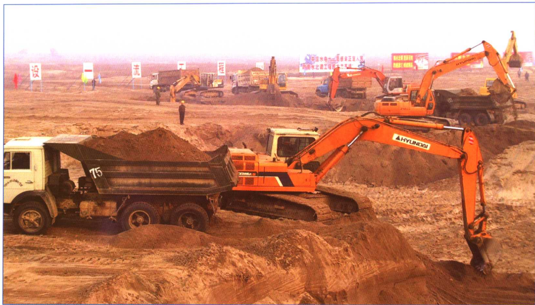
■ 2003年12月，南水北调中线京石段应急供水工程滹沱河倒虹吸工程开工建设。
