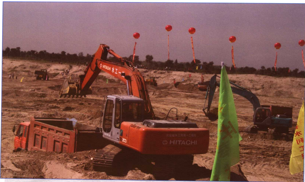
■ 2004年9月，南水北调中线京石段应急供水工程唐河倒虹吸工程开工建设。
