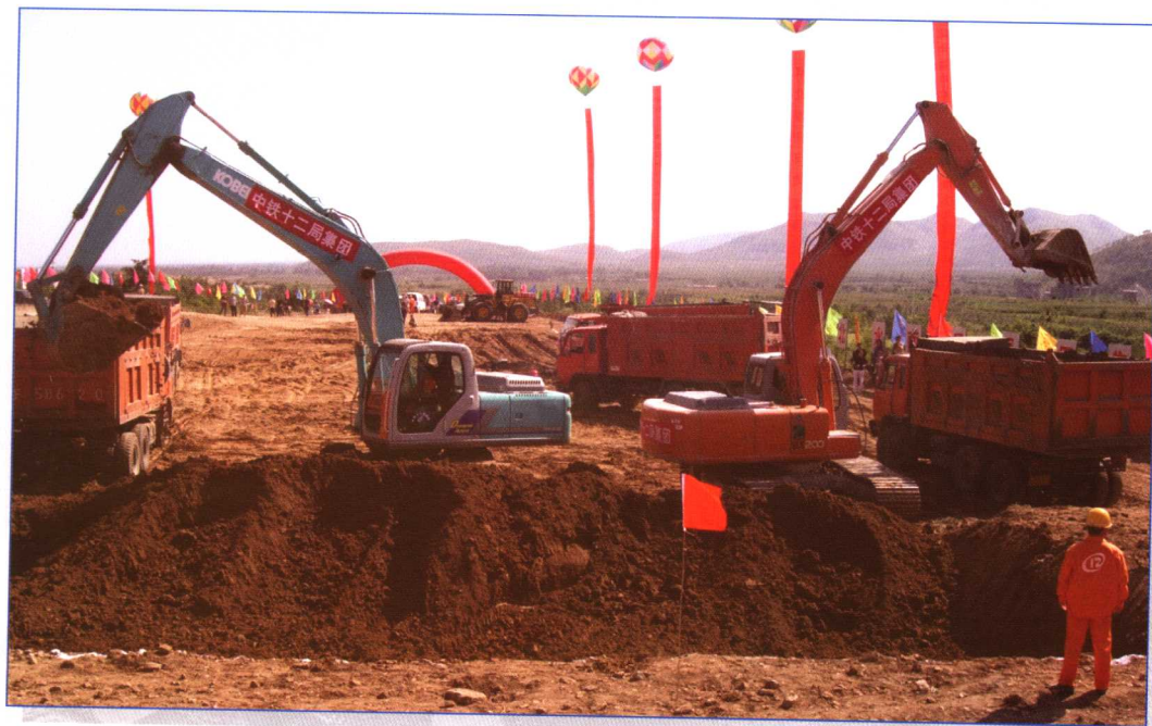
■ 2004年9月，南水北调中线京石段应急供水工程釜山隧洞工程开工建设。
