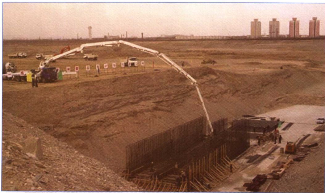
■ 2004 年 3 月，南水北调中线京石段应急供水工程永定河倒虹吸工程施工现场。
