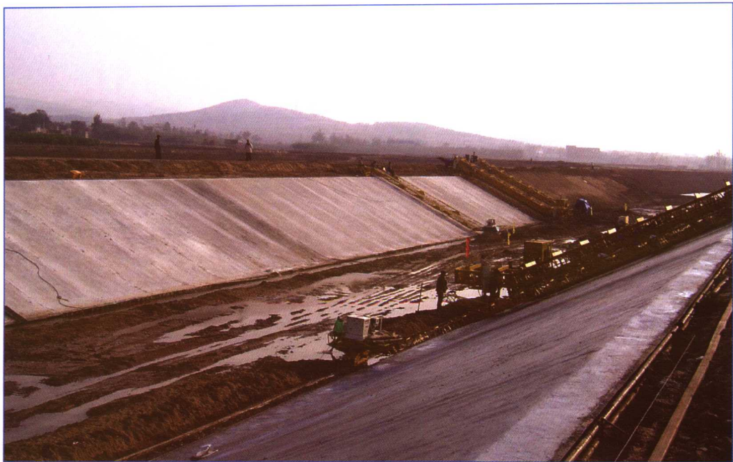
■ 2003 年 10 月，南水北调东线济南至东平湖输水干渠工程施工现场。
