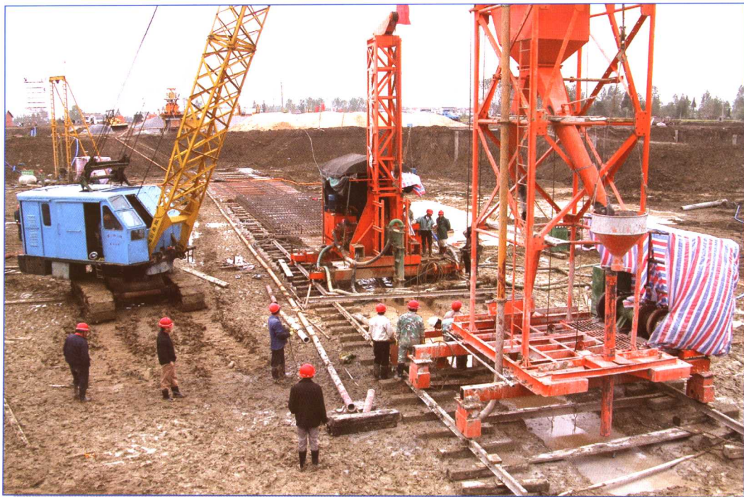
■ 2003年10月，南水北调东线宝应站工程施工现场。
