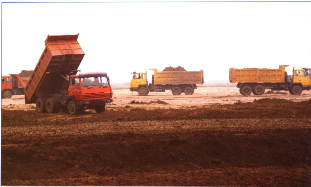
■ 2004 年 11 月，南水北调东线韩庄运河工程施工现场。
