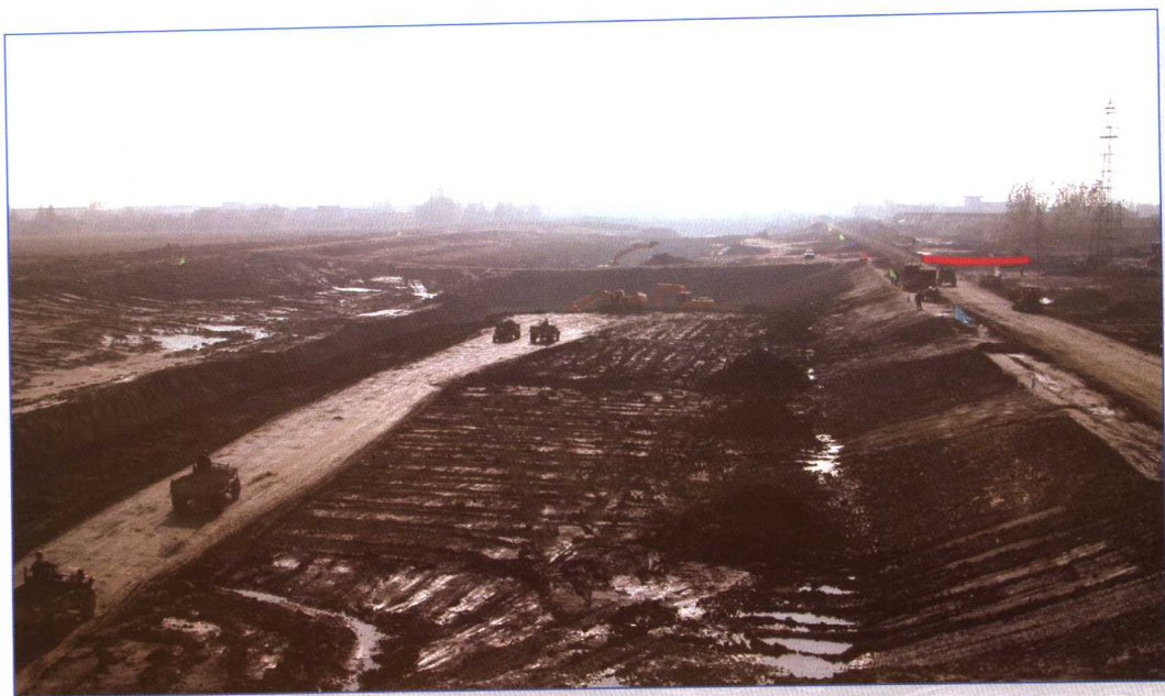
■ 2003年11月，南水北调东线三阳河工程施工现场。
