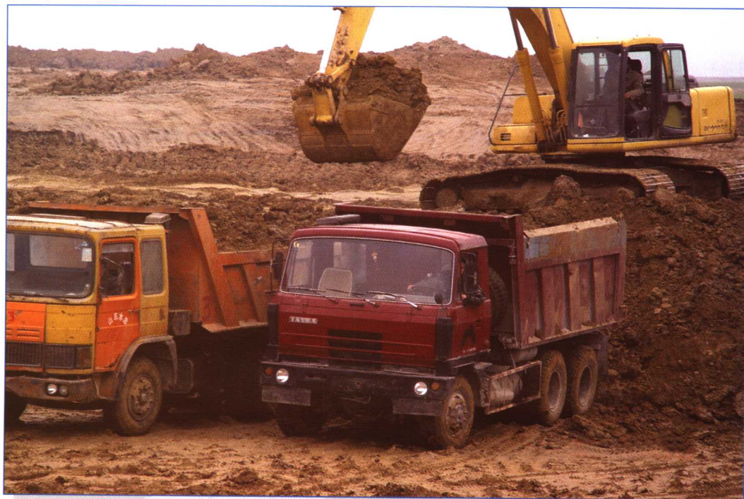
■ 2004 年 12 月，南水北调东线韩庄运河工程万年闸泵站基坑开挖。
