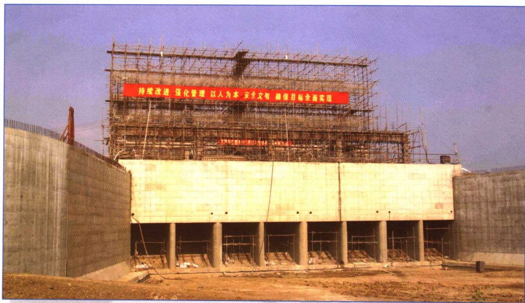
■ 2004年7月，南水北调东线宝应站工程施工现场。
