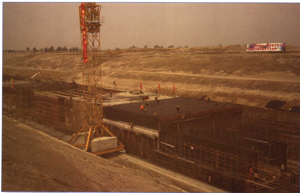
■ 2004年5月，南水北调中线京石段应急供水工程滹沱河倒虹吸工程施工现场。
