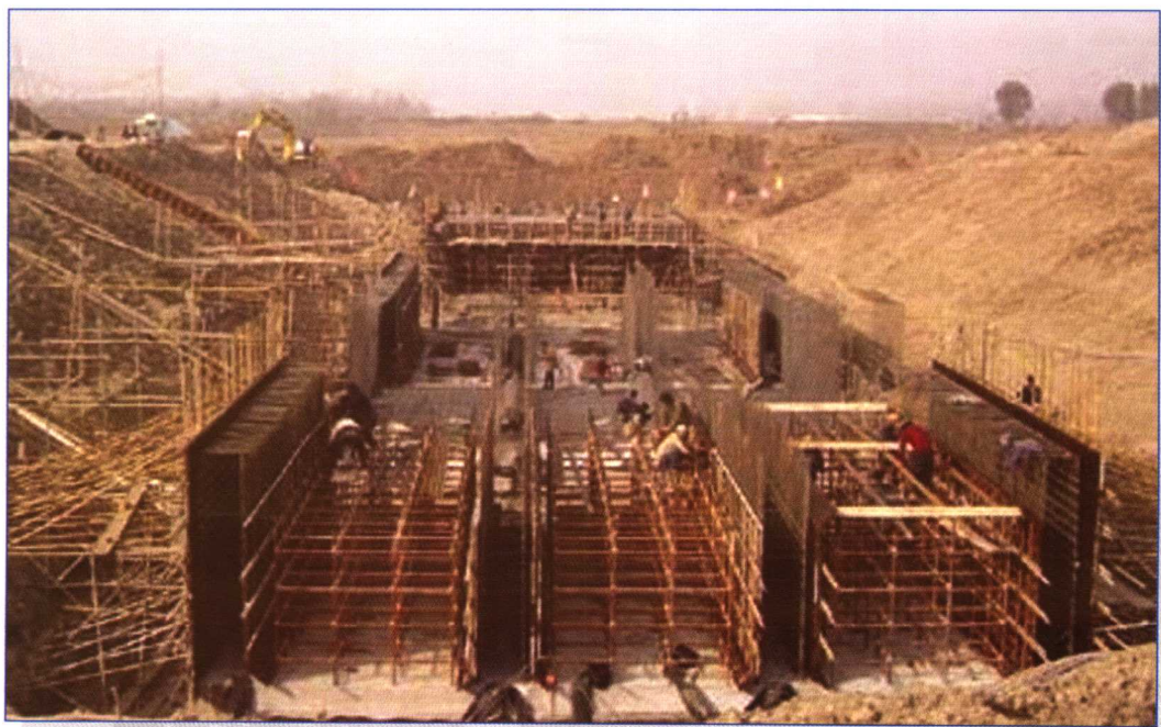
■ 2004 年 1 月，南水北调东线济南至东平湖输水干渠施工现场。
