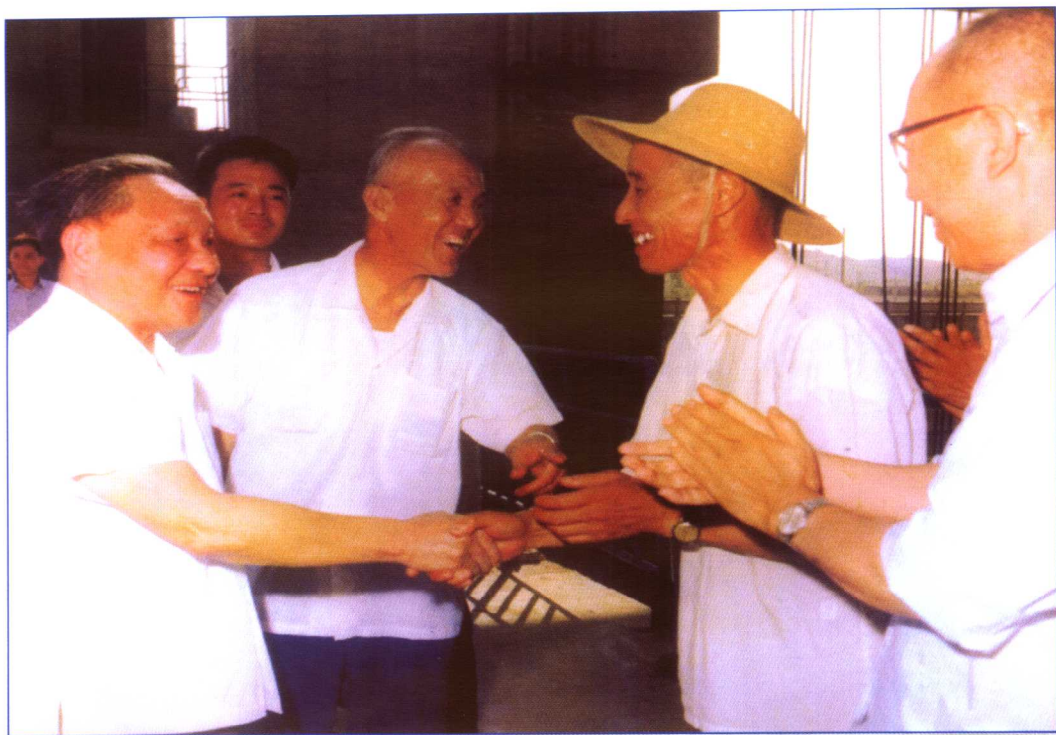
■ 1980年7月，邓小平同志视察了丹江口水利枢纽工程，详细询问了丹江口水利枢纽初期工程建成后防洪、发电、灌溉效益与大坝二期加高情况。
