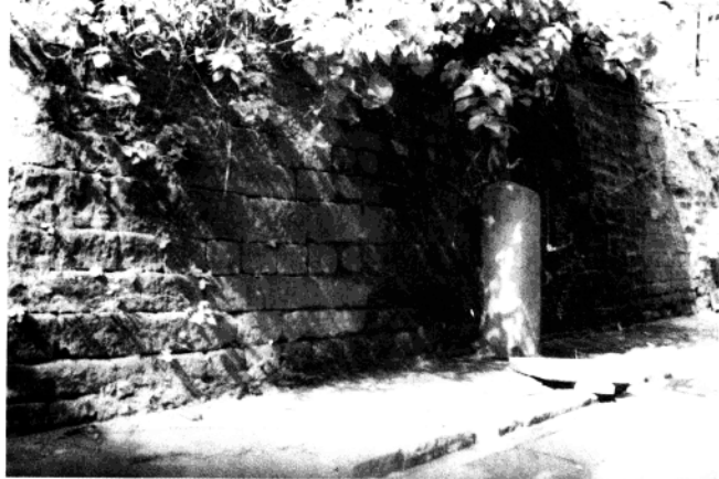
▲西门口庆南坊内古城墙脚遗址。
