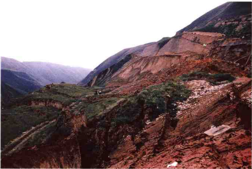
照片 1—4 滑坡的反坡平台
