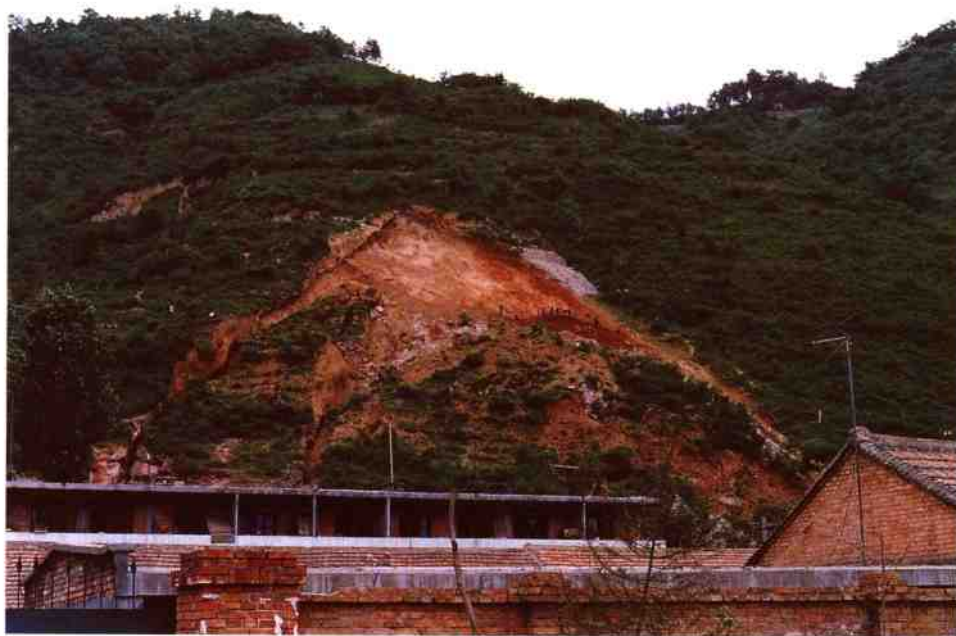
照片 2—3 宝成线 K105 顺层岩石滑坡
