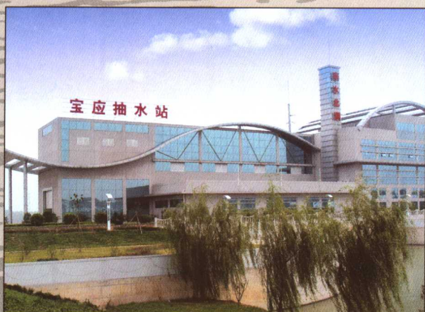
南水北调东线一期宝应站工程
