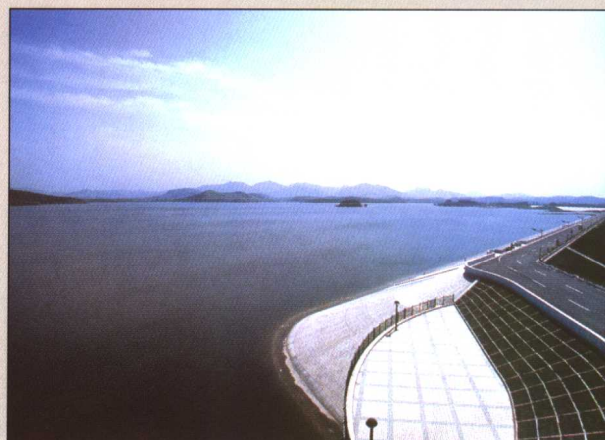
江苏宜兴横山水库除险加固
