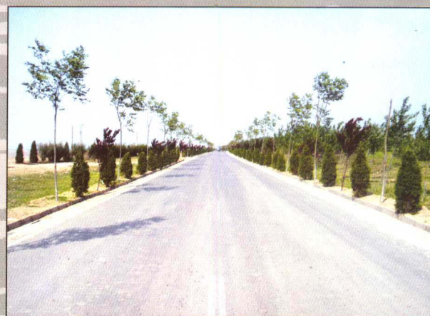
黄河下游建成后的堤顶公路
