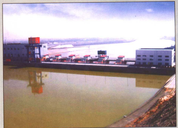
已建成的沙坡头水利枢纽工程
