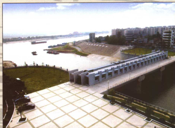
珠江流域北江大堤芦苞水闸
