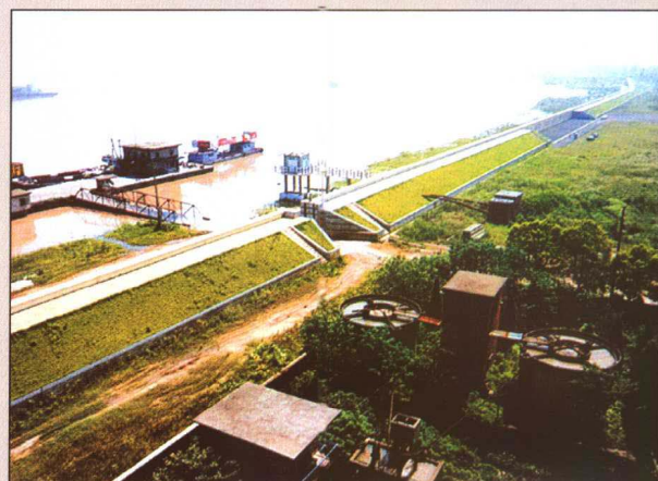
加固后的江西长江干堤工程
