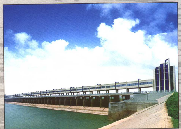
建设中的临淮岗水利枢纽工程
