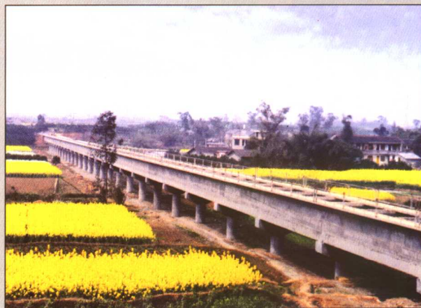
四川都江堰灌区改造工程广济渡槽
