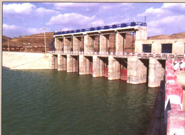
除险加固后的宁夏南部山区水库
