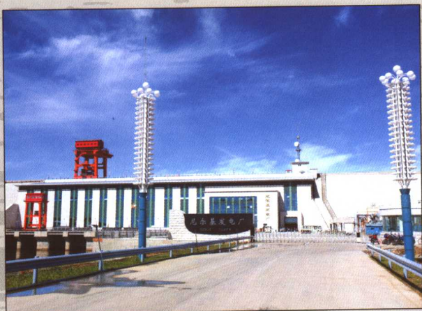
建设中的尼尔基水利枢纽工程
