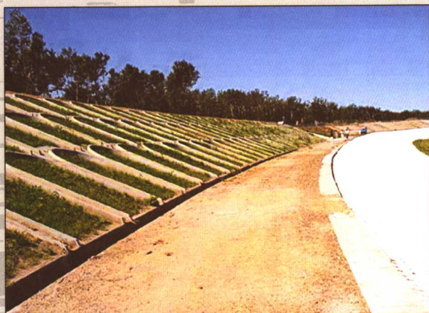
建成的松辽流域嫩江右岸省界堤防
