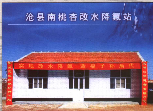
河北沧县氟砷改水工程
