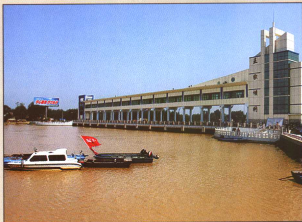
水毁后重建的淮河王家坝大闸
