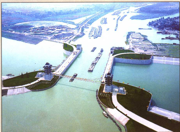
淮河入海水道淮安枢纽立交远景
