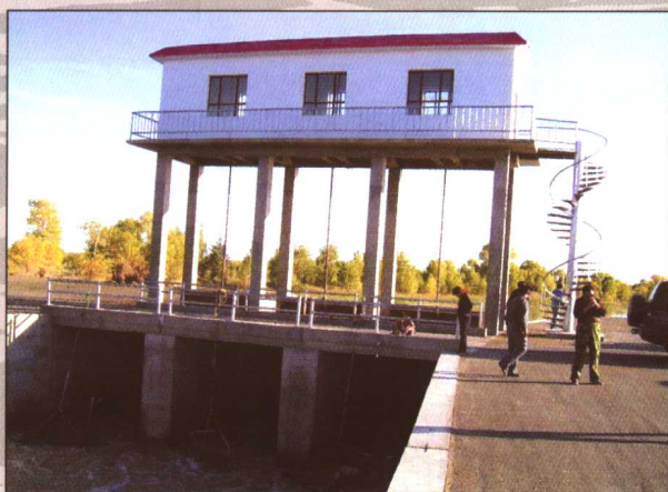
塔里木河灿木里克生态闸工程
