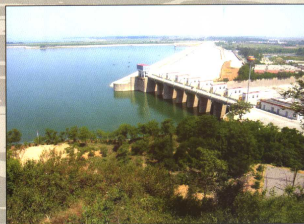
除险加固后的河北黄壁庄水库
