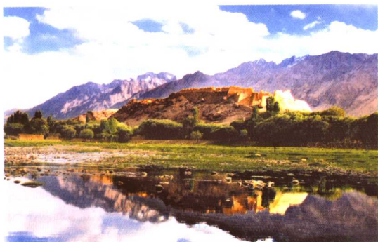
彩图 25 塔什库尔干塔吉克自治县，古称羯盘陀，风光神奇，塔吉克族风情浓郁。图为该县城内著名的古迹“石头城”。（潘继鹏）
