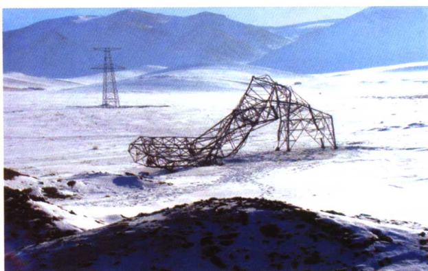
彩图20 2004年11月24日乌鲁木齐南郊乌拉泊12级东南大风竟然吹倒了高压线的铁塔。（窦新英）
