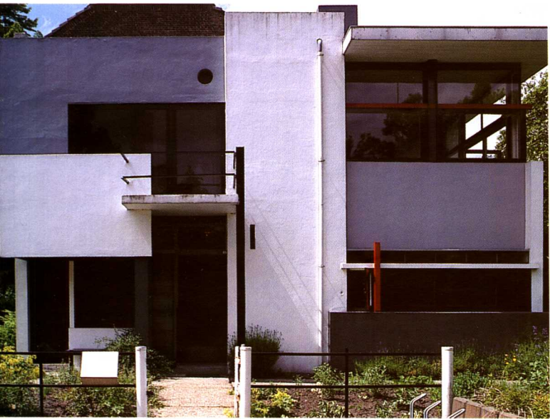
上图：盖里特·里特维尔德设计的斯库尔德住宅(Schröder House, 1925年)特别强调不对称感，奇特怪诞的建筑细节完全改变了它的结构与布局。比如说，当一楼的两扇窗户打开至一定的角度时，会营造出建筑墙角消失的效果
