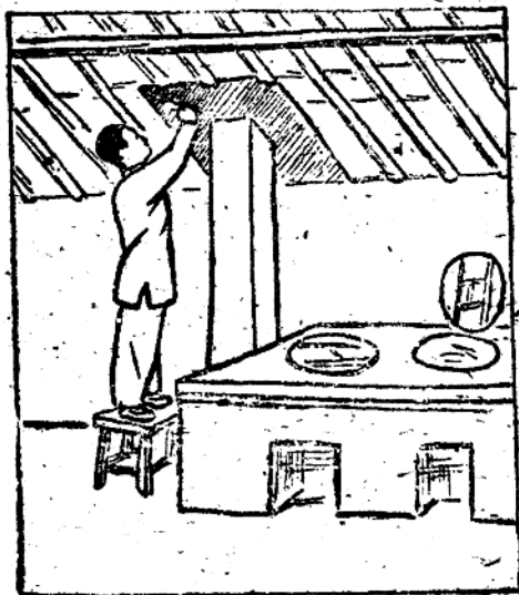
图2 用泥土将烟囱与屋顶隔开
