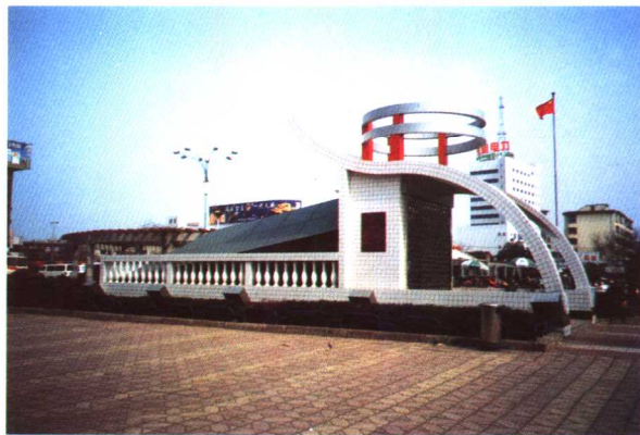
市中心广场人防工程一号入口处
