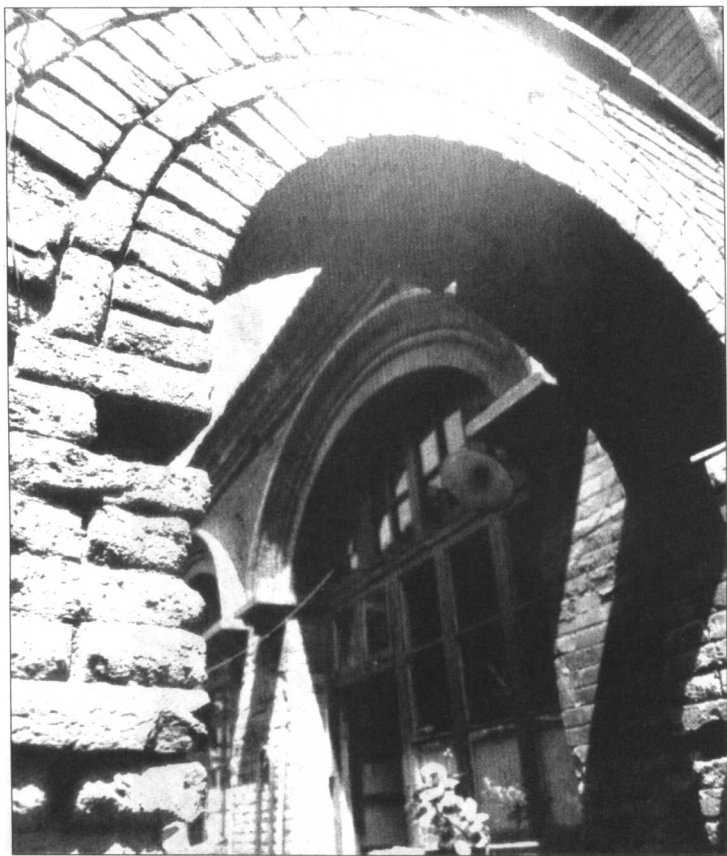
岁月剥蚀了墙体，墙体记录了历史
