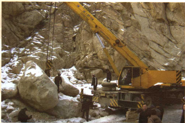
◎湘女石起吊现场↑
