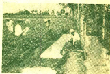
涇惠渠用溝灌法灌溉棉田
