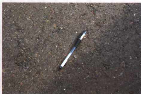
施工后的泡沫沥青层表面
