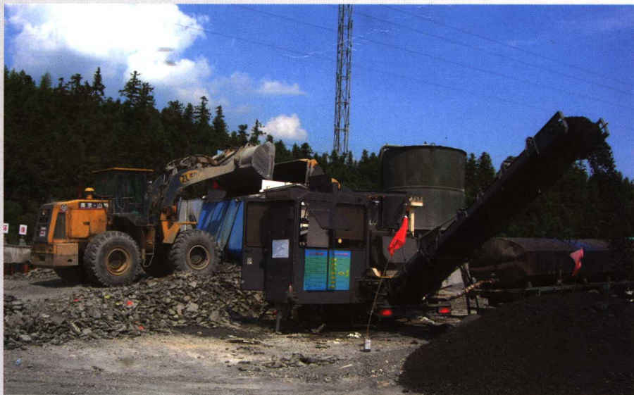
泡沫沥青厂拌施工现场
