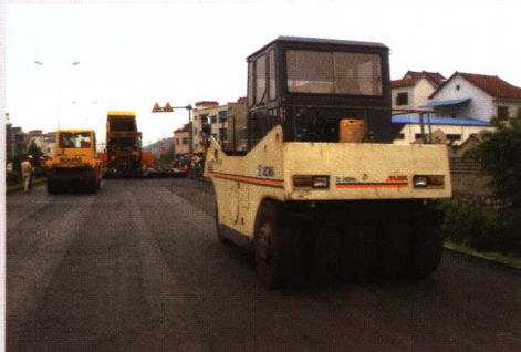
泡沫沥青再生材料的现场摊铺
