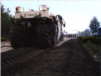
泡沫沥青就地再生施工现场
