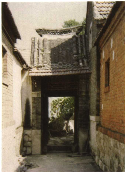
小巧玲珑的起凤桥5号院小门楼（1989年摄）
