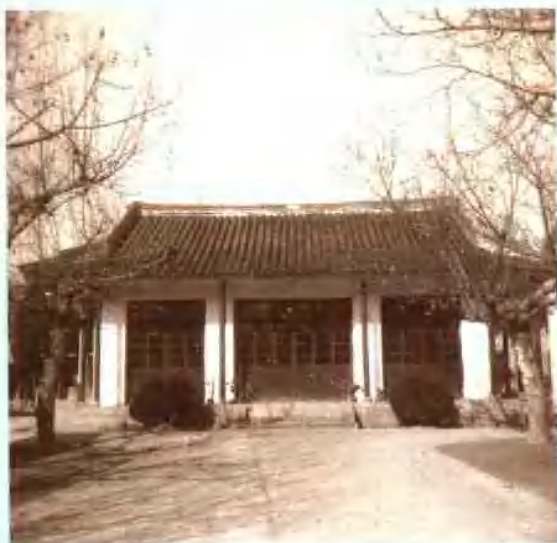
江苏省昆山中学西塘街校区的早期标志性建筑“忠烈祠”，俗称“四角亭”(1991年拆除)
