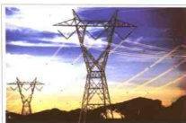
中国信保承保国外大型电站项目
