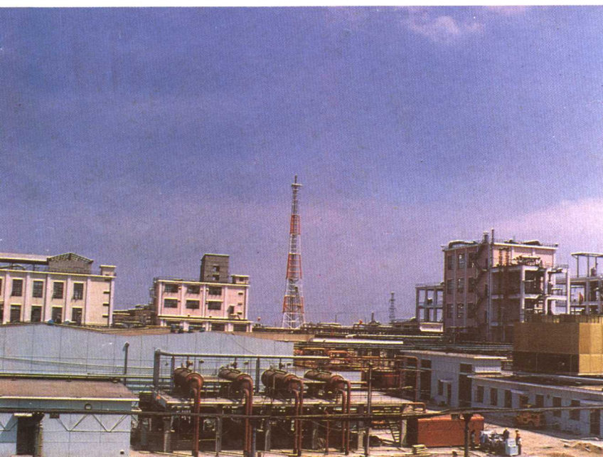
◀ 天津化工厂 1 万吨 级饲料蛋氨酸设备装置区 外景
