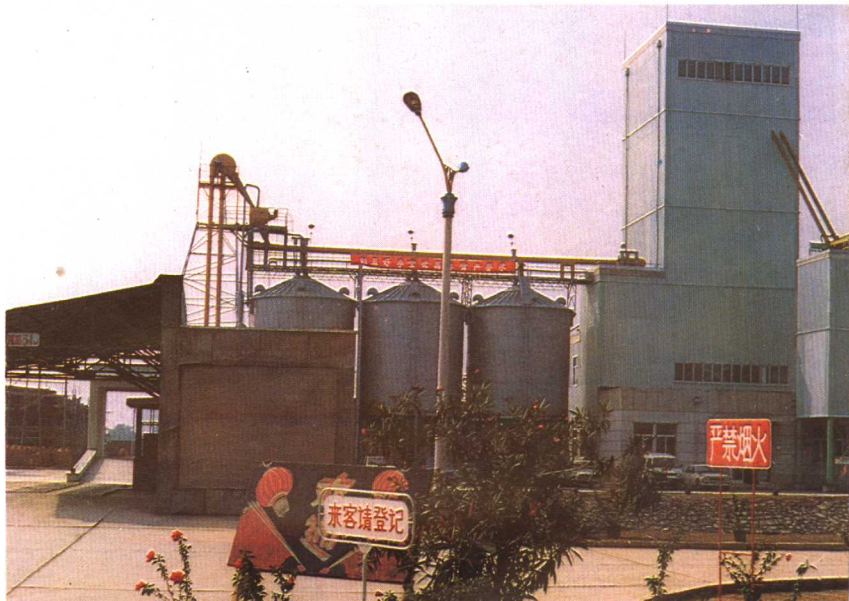
由北京市饲料科研所 设计,全部采用国产设备、 国产微机实现自动控制的 全国第一个万吨级钢结构 配合饲料厂——北京通县 配合饲料厂于1986年建成 投产 ▶
