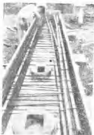
图 14 安装后张法制作的铁皮管
