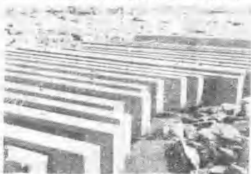
图 11 鋼弦混凝土基础梁
