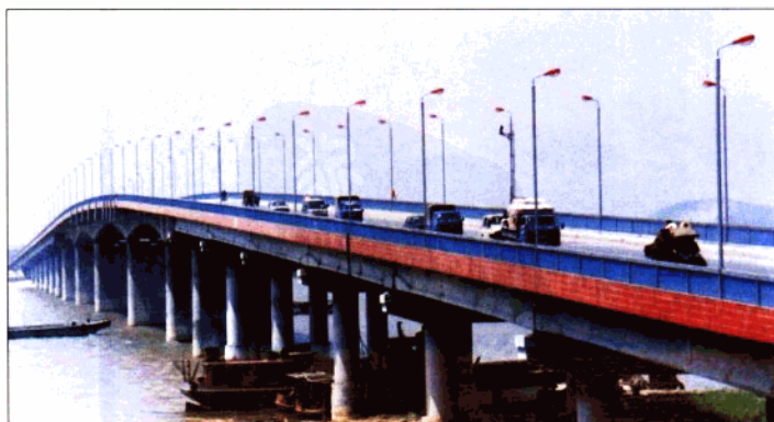
扬中长江大桥
