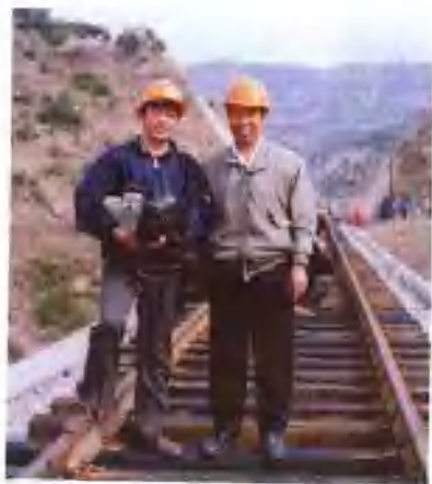
晋中地方铁路局局长、阳涉铁路总指挥王文林在和顺铁路工地
