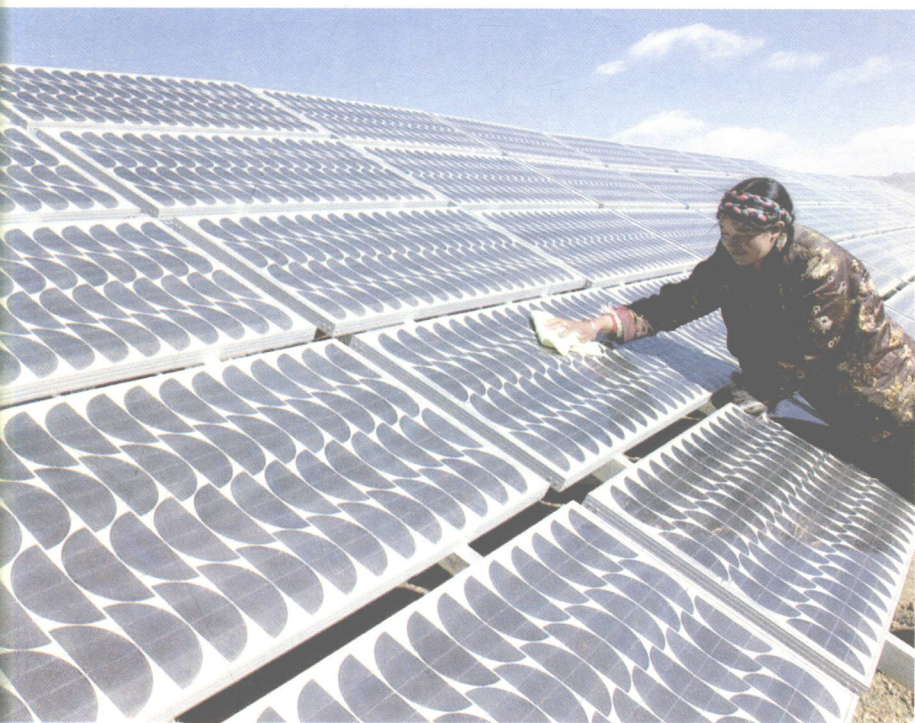
哲古镇光伏电站装机容量达130千瓦，它的建成结束了西藏山南地区乡镇不通电的历史。西藏措美县哲古镇光伏电站的管理员在擦净硅光板上的尘土。
