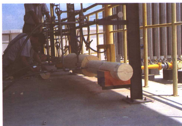
(低温保冷管道施工)
