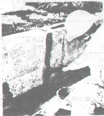
舊混凝土內填塞裂縫
