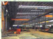
公司集中供气在石家庄开发区金环钢构公司使用
