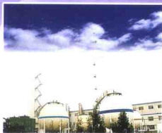
↑ 河北前进钢铁集团公司 1 st 、2 nd 空分项目
