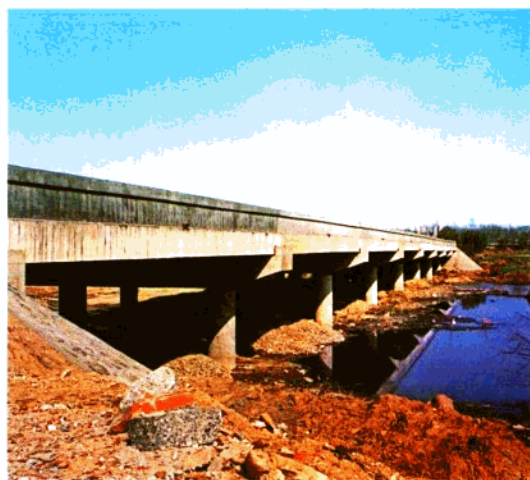
正在建设中的邵阳浉河大桥
