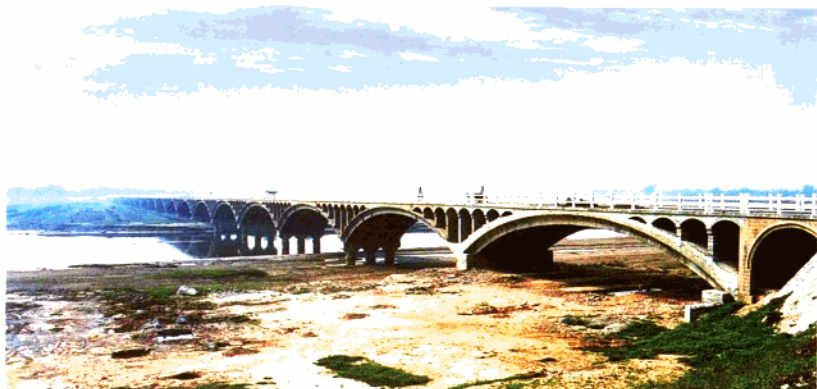
武陟县红旗大桥
