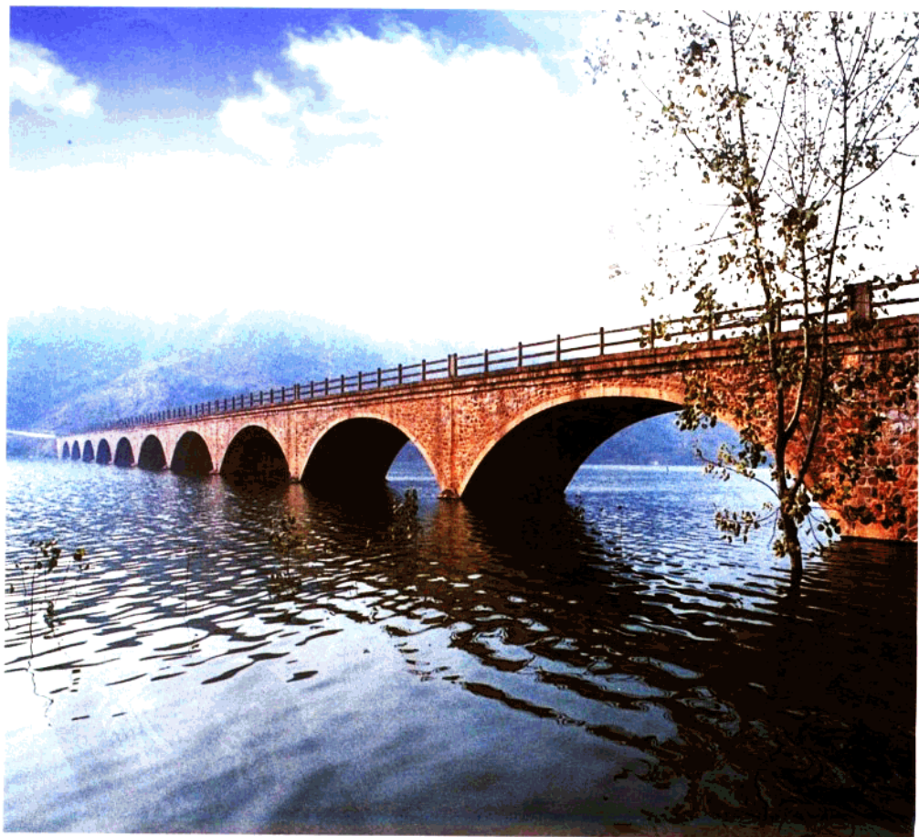
通往山区的平岭大桥
