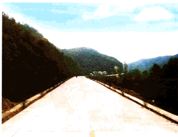
新修的县道二级公路
