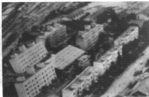
图 1-12 砂土液化使公寓楼整体倾斜
