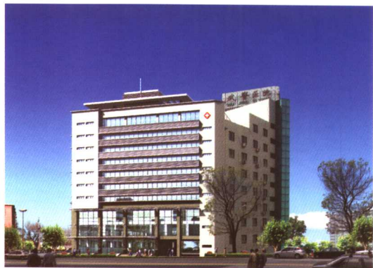
武警江苏总队南京医院科技综合楼
