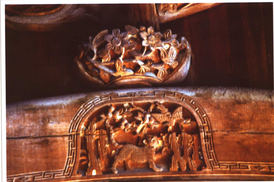
祁门会源堂古戏台梁枋细部
