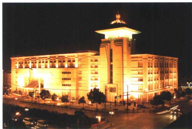
苏州国税综合业务大楼-2004年度鲁班奖
