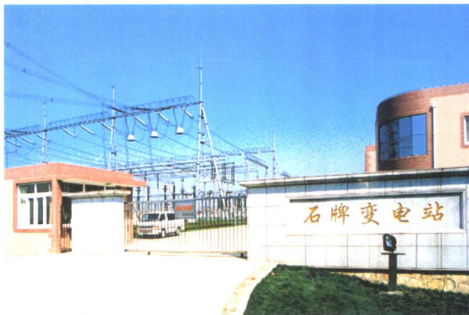
500KV 石牌变电站-2003年度鲁班奖
