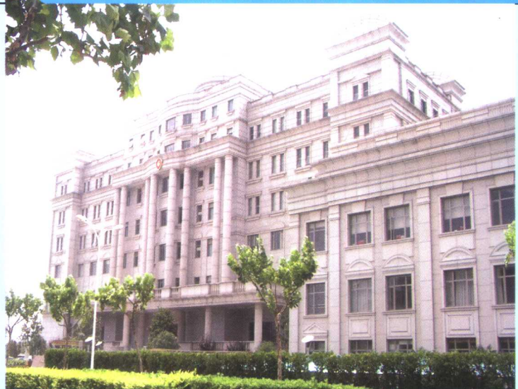
上海工商行政管理局松江分局办公楼获 2004 年度上海市建设工程“白玉兰”优质工程奖
