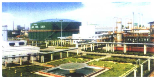
南京市 50 万立方米 / 日轻油制气工程，由本公司总承包施工，2000 年获“鲁班奖”。
